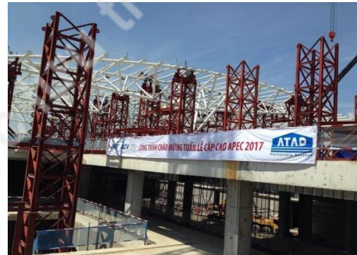
Sân bay quốc tế Đà Nẵng Dự kiến hoàn thành 30/4/2017
