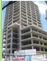
LIM TOWER 2 158 Võ Văn Tần, Quận 3 GFA: 20,467 m 2
