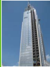
VIETCOMBANK TOWER 5 Công trường Mê Linh, Quận 1 GFA: 55,000 m 2
