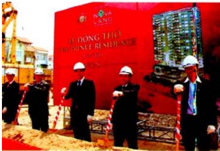
tài mớng cọc dự án The Prince Residence
