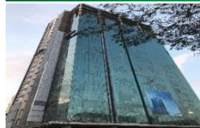
UOA Tower, Quận 7 NLA: 29.940 m²
