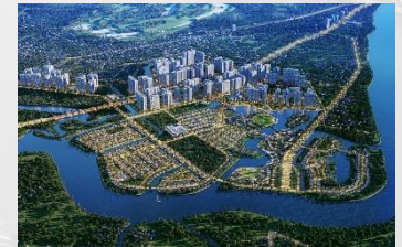
Vinhomes Grand Park, Q.9 6.000 căn gia đoạn 2
