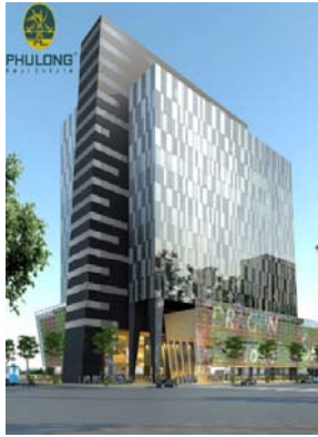
Dragon Tower, Nhà Bè
